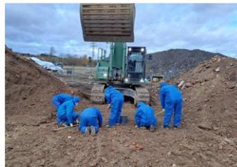
Einweisung des Baustellenpersonals in die Arbeiten zur Separierung von Bauschutt, Asbestbruch und asbesthaltigen Böden. Analytische Freimessungen und Deklarationsanalysen der jeweiligen Bauschutt- u. Abfallfraktionen.
